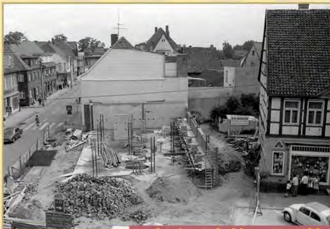
Baubeginn Schuhhaus Wotschke, Marktstraße/Ecke Poststraße
